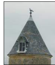
Portail et toit du pigeonnier au Gué-Charreau
